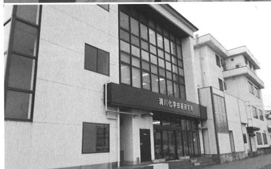
本社の一角にある清川化学技術研究所は技術開発のほか、めっきの分析も行う部門。施されためっきの状態を観察・分析する。また、他企業向けの分析サービスも行っている。建物1階フロアの一部は見学コースとして公開されている。
